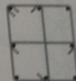
(b) 拉筋紧靠箍筋勾住主筋
