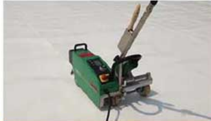
TPO机械焊接施工
