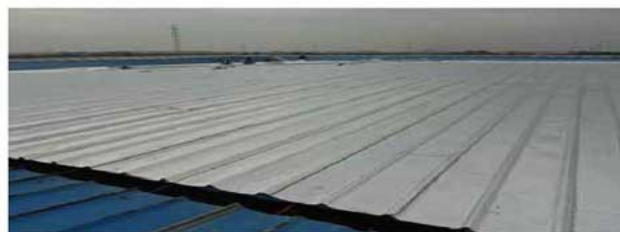
ALB 隔热铝箔丁基橡胶自粘防水卷材在金属屋面上的应用
