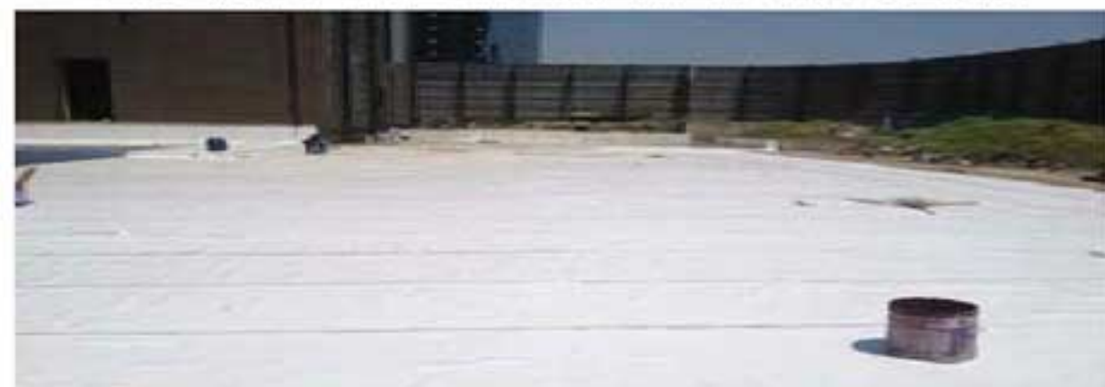
POB 热塑性聚烯烃丁基橡胶自粘防水卷材在金属屋面上的应用
