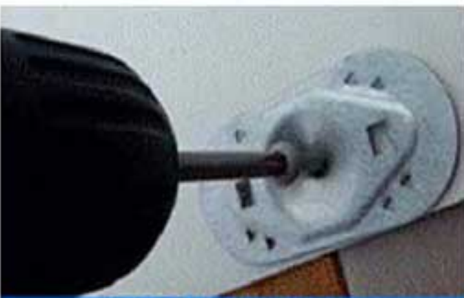
TPO卷材机械固定
