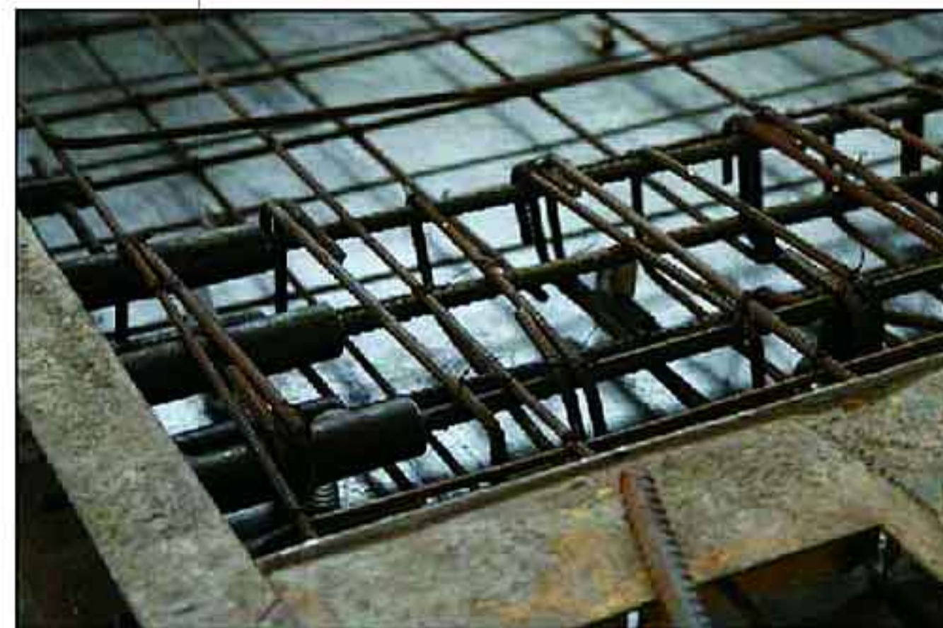
预制墙板内置钢筋局部（一）
