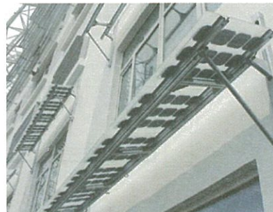
光伏遮阳板遮阳 — 水平式
