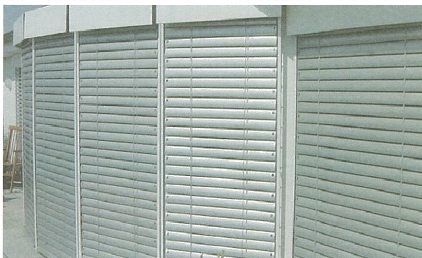
百叶帘遮阳 — 导轨导向式
