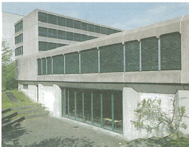
百叶帘遮阳 — 导轨导向式
