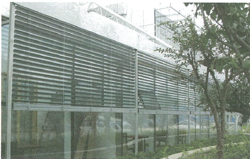
百叶帘遮阳 — 导轨导向式
