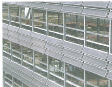
光伏遮阳板遮阳 — 水平式
