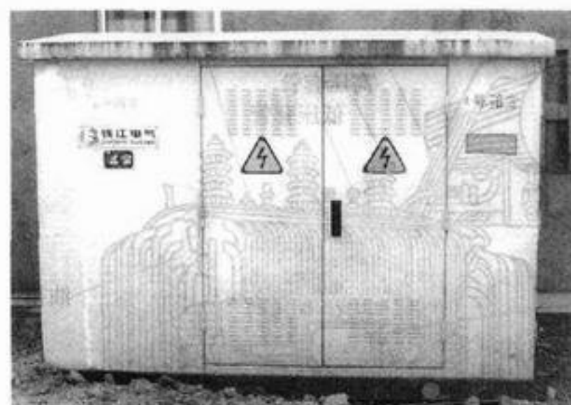
a) 户外地台上安装变压器的实物图
