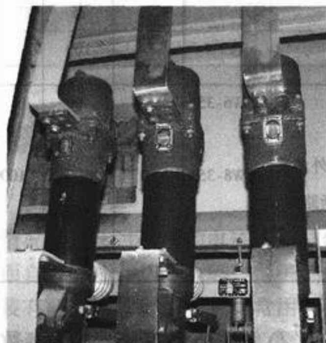
图 4-5 油断路器的外形
