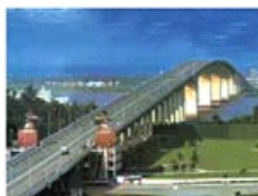
图 3.5-4 高大的桥要造很长的引桥,减小斜面的倾角。
