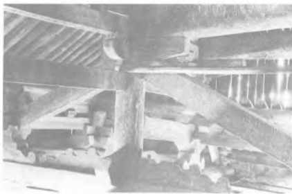
e 转轮藏殿屋顶下结构 注意其对结构构件的具有特色的艺术处理。
