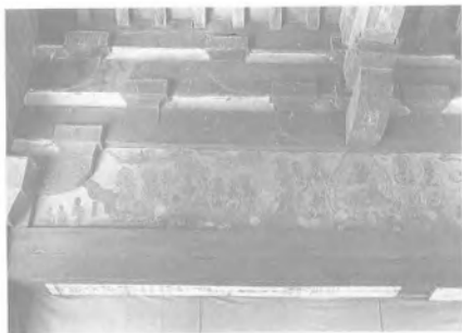
f 佛光寺大殿内槽斗拱及唐代壁画 g 屋顶构架
