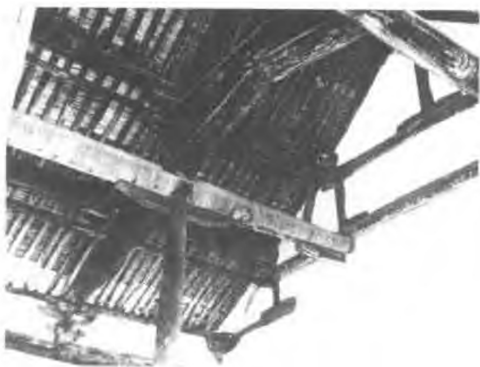
第 115 图 山西赵城县广胜寺下寺前殿梁架(元) (前后用三椽斜挑大梁交于平梁正中之下)
