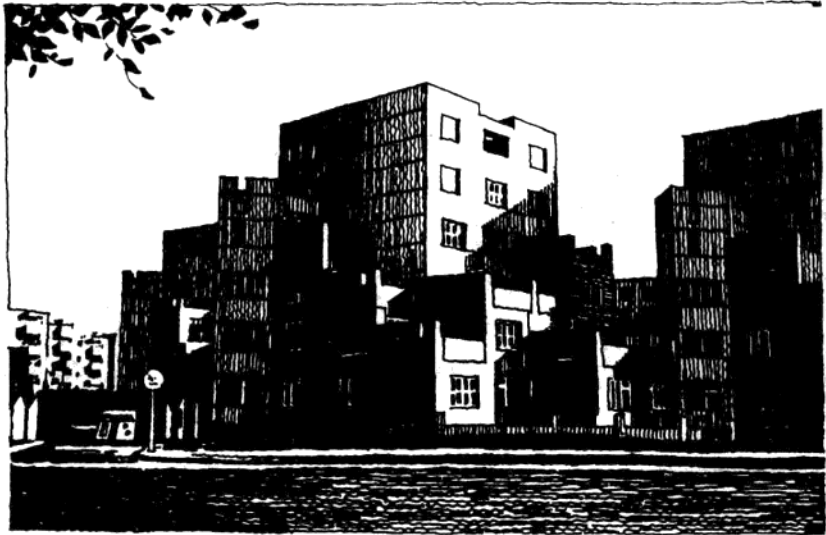
图 7-13 调整各层套型数量形成退台，使每户有露台花园 (天津川府新村花园台阶式住宅)
