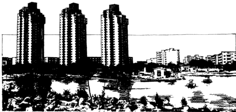
图 7-49 综合处理的高层住宅顶部 (天津体院北高层住宅, 顶部层层退台, 改变材料和色彩)
