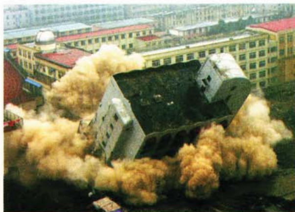
图7-17 利用炸药爆破拆除楼房
