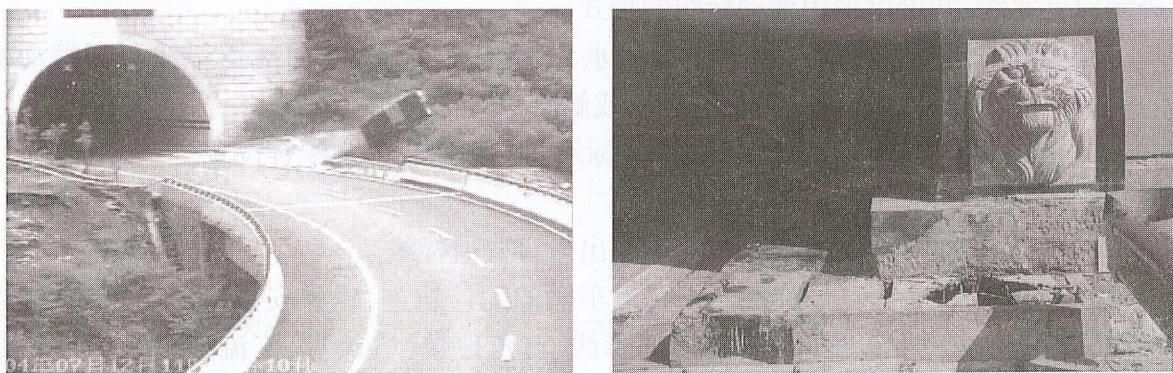
图 5-2 端墙式隧道洞口交通事故示例
