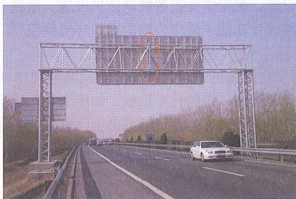
注：图中椭圆形红色曲线内为现有横梁法兰盘 b) 适应于公路路基远期需要加宽的门架式交通标志结构设计示例
