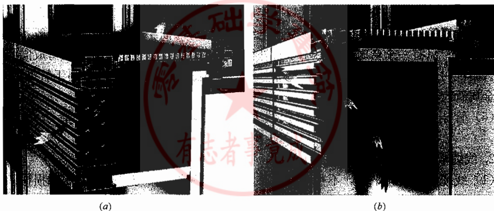
图 22-88 双层幕墙进排风口示意图 (a) 进风口示意图; (b) 排风口示意图
