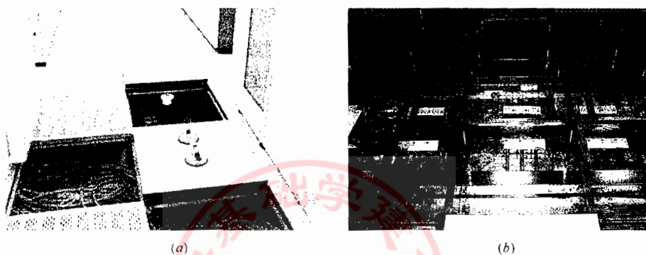
图 36-89 机房抗静电地板的敷设 (a) 地板的上板; (b) 地板下安装的槽道与电气插板
