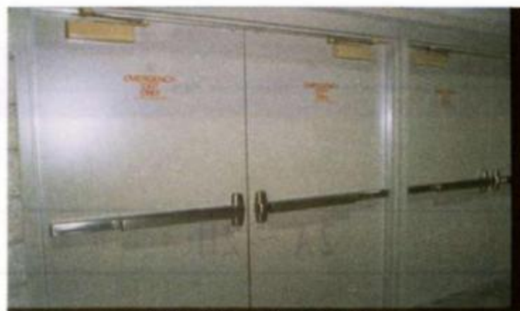
推杠型，暗装插销式 安装在平开木门或平开钢门上
