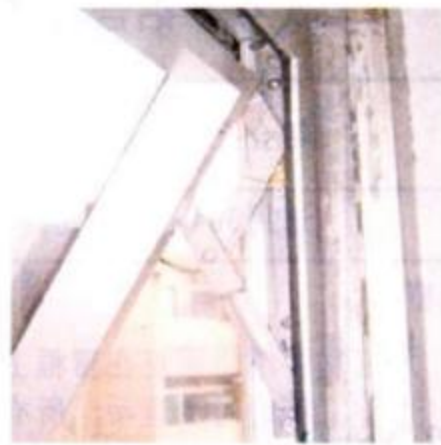
上悬窗滑撑 安装示意图
