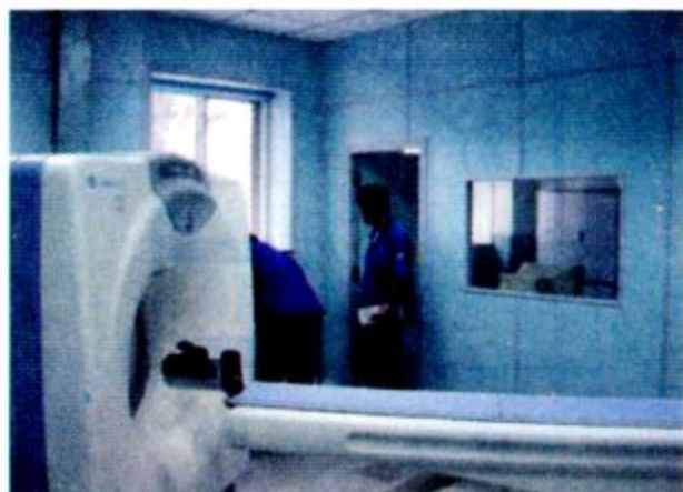
防火板饰面射线防护机房
