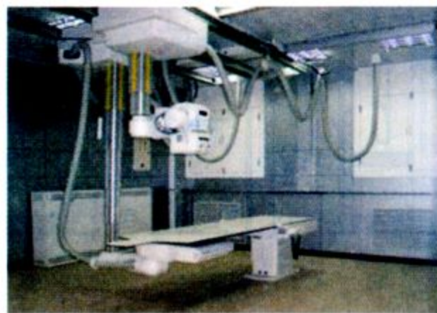
铝塑板饰面射线防护机房
