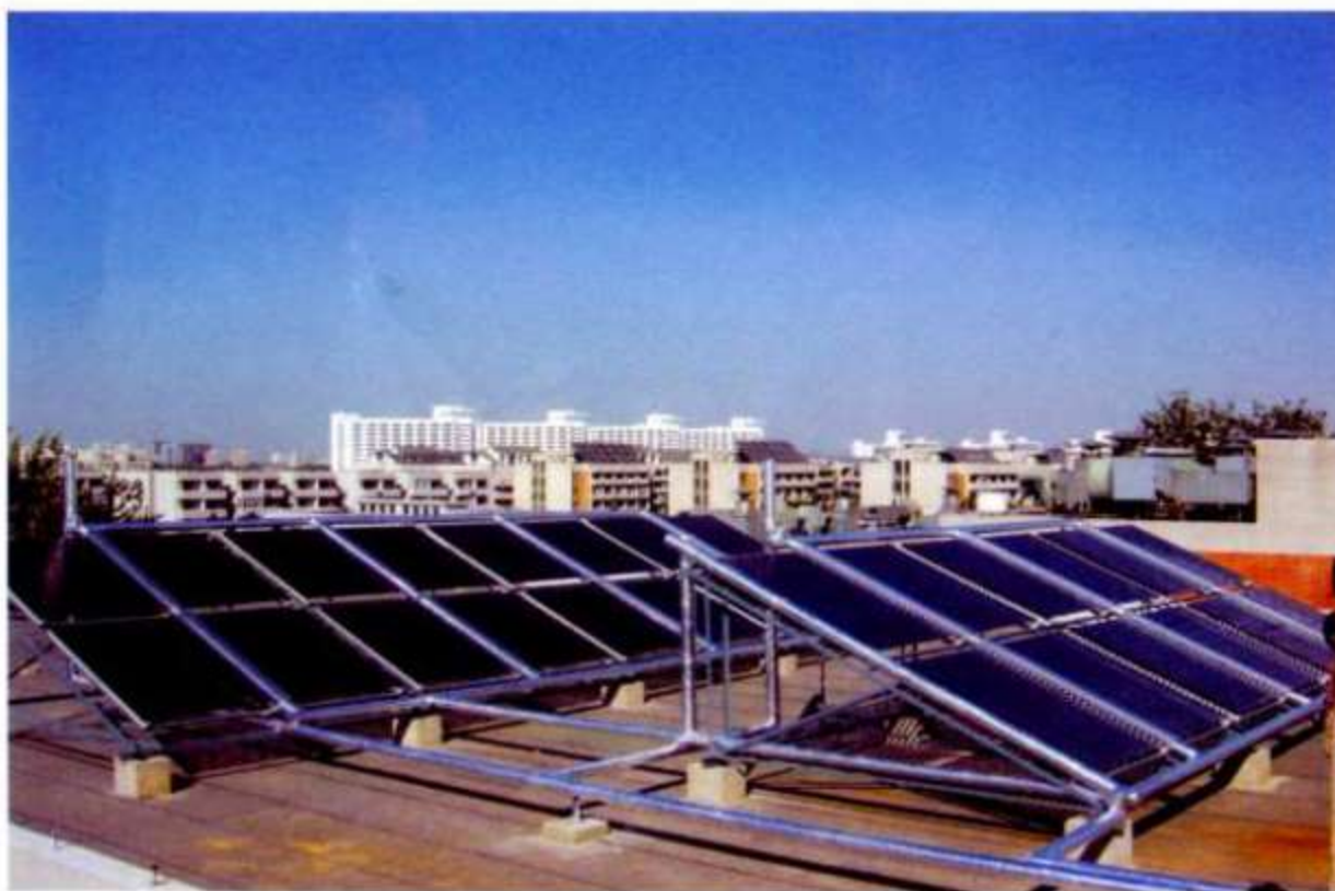
清华大学联集管式太阳能热水系统
