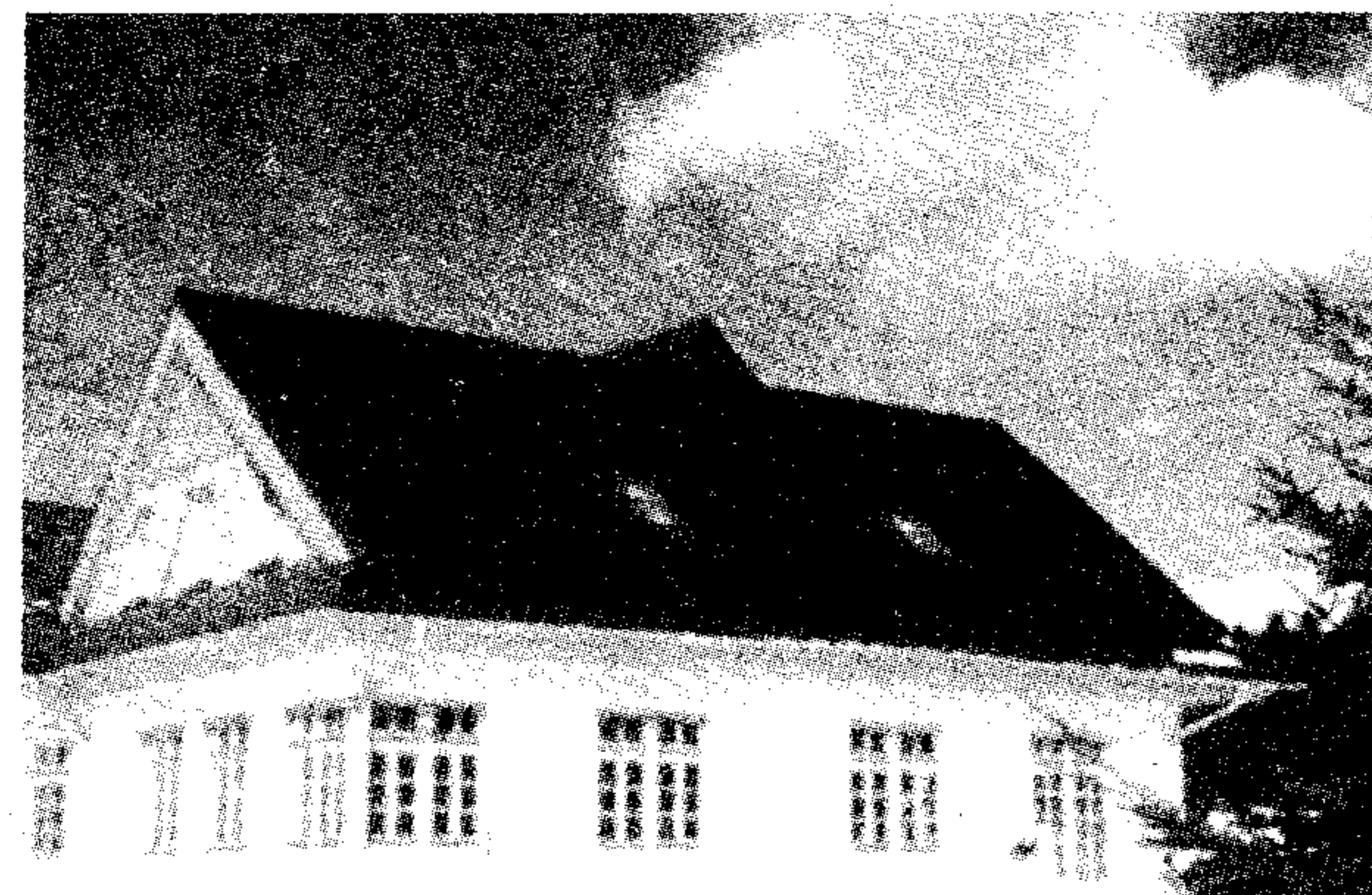
太阳能集热器安装在坡屋面
