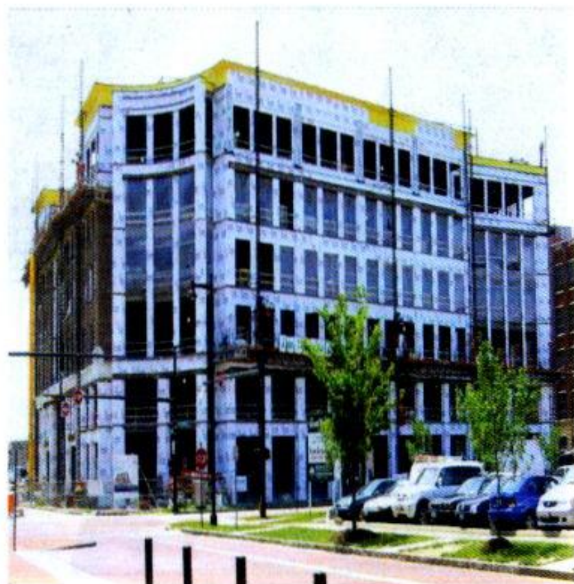
瓷板幕墙保温层外覆防水透汽膜
