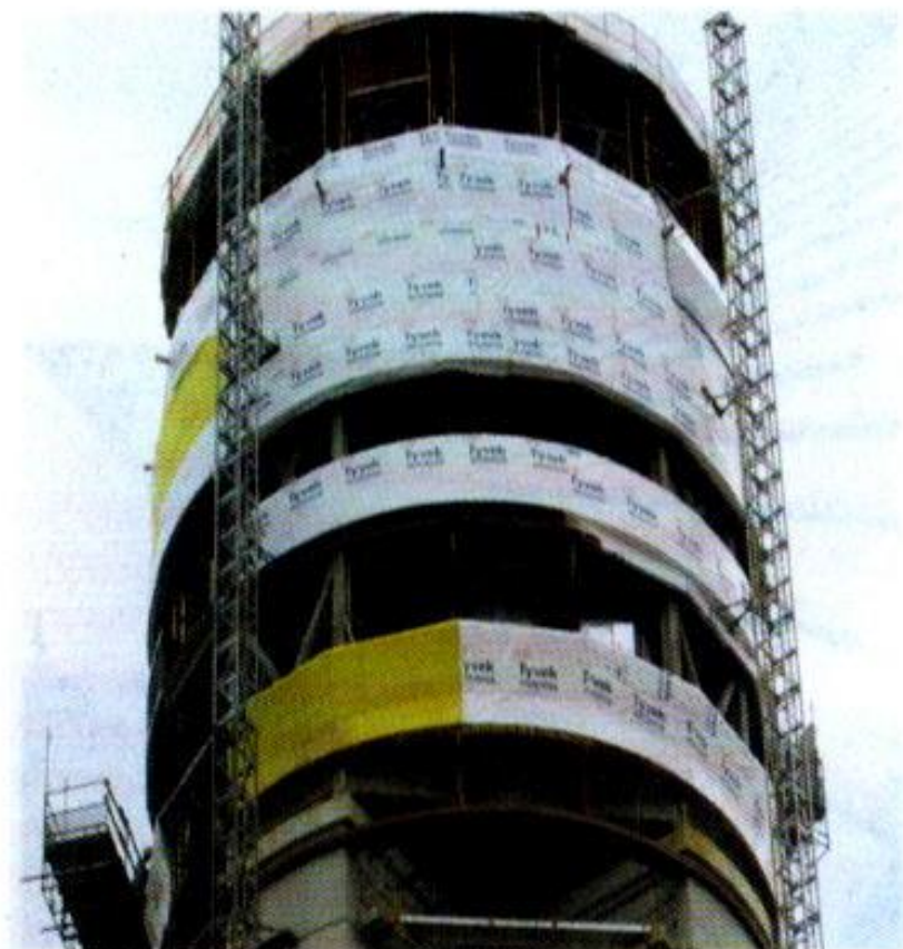
铝板幕墙保温层外覆防水透汽膜
