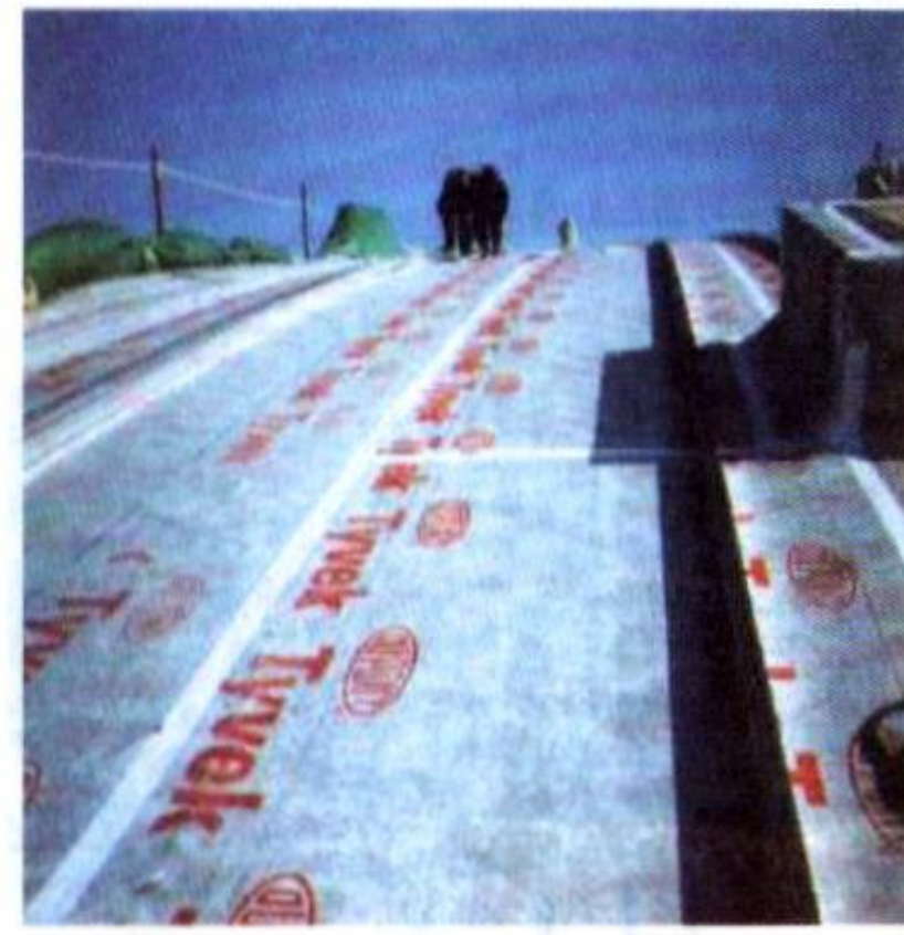
大跨度弓形屋面保温层上(外)覆防水透汽膜
