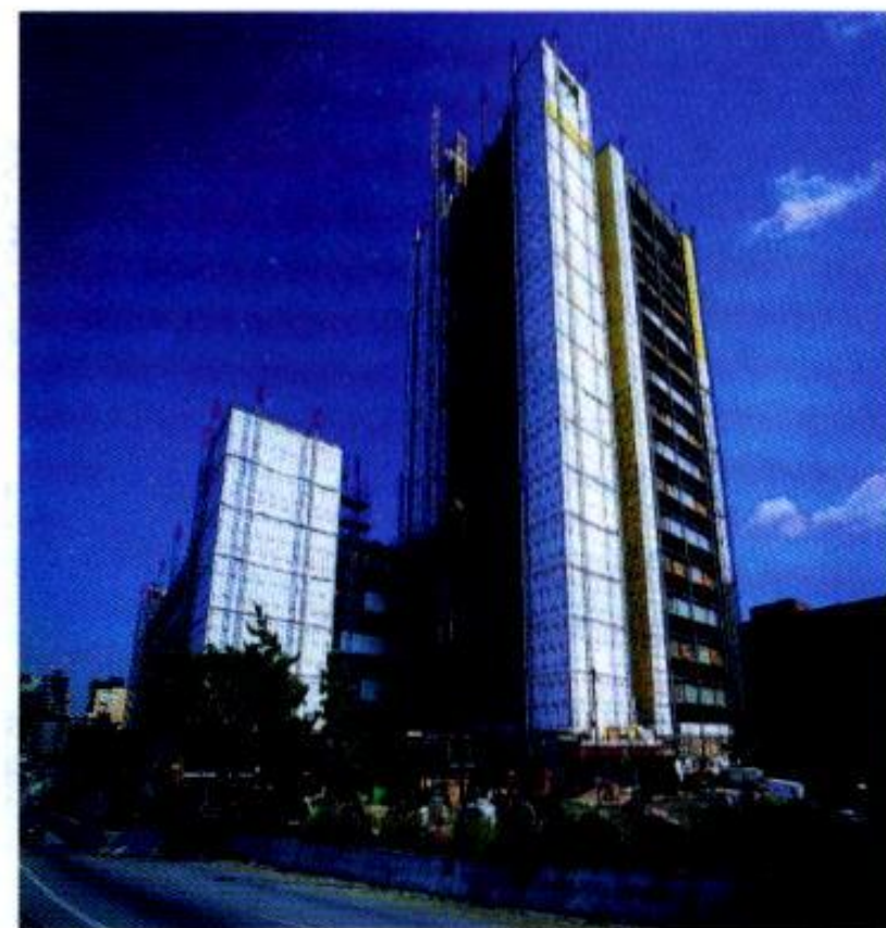
高层住宅外墙保温层外覆防水透汽膜
