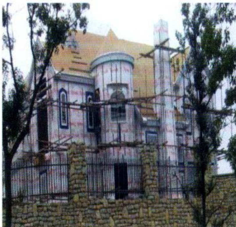
别墅外墙保温层外覆防水透汽膜
