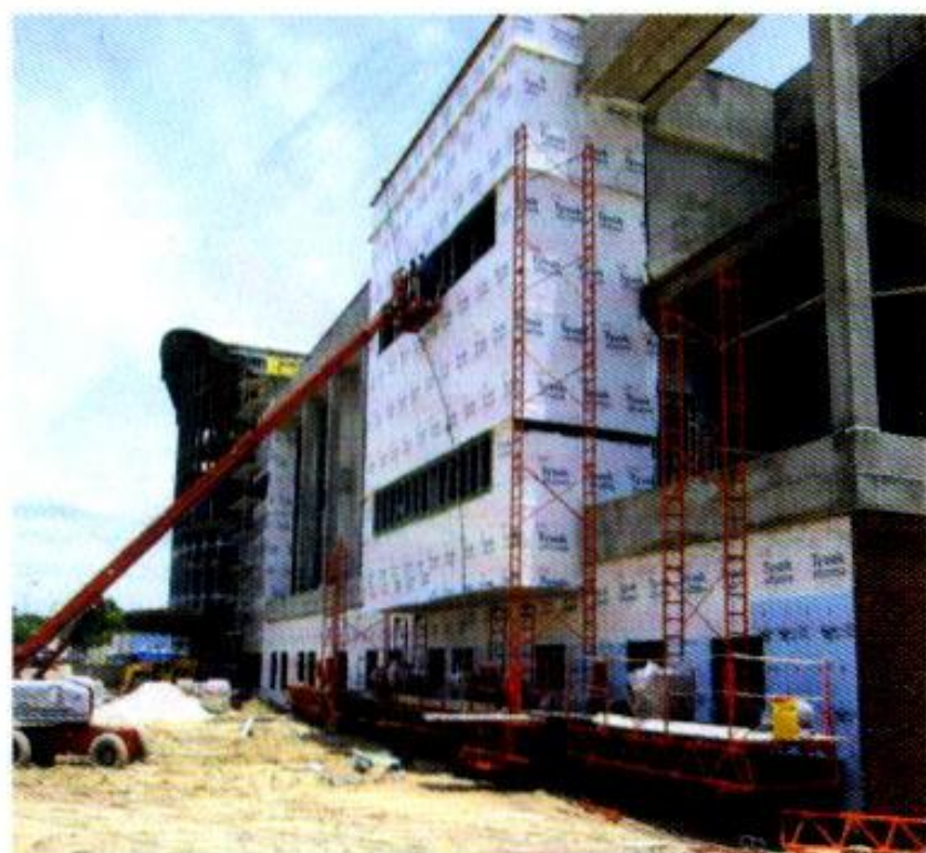
公建幕墙保温层外覆防水透汽膜
