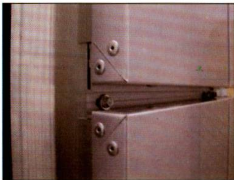
板块横向 铝型材上下插接
