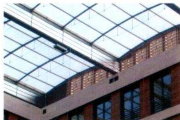
张拉弦拉索桁架采光顶实例
