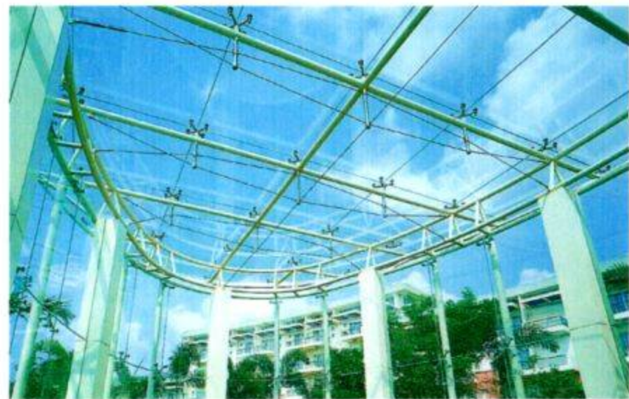
拉索桁架采光顶实例图片
