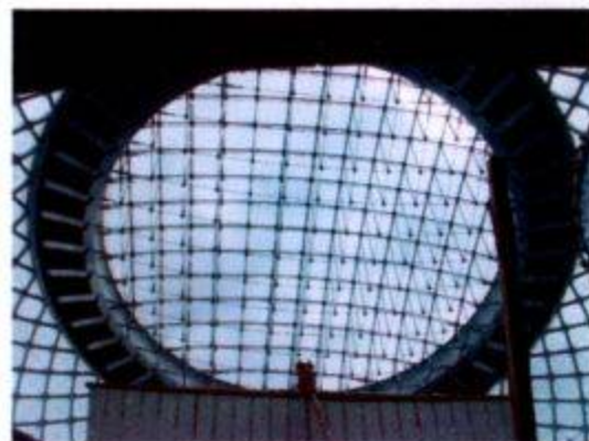
图4 拉索拉杆采光顶实例
