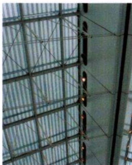
图2 拉杆采光顶实例
