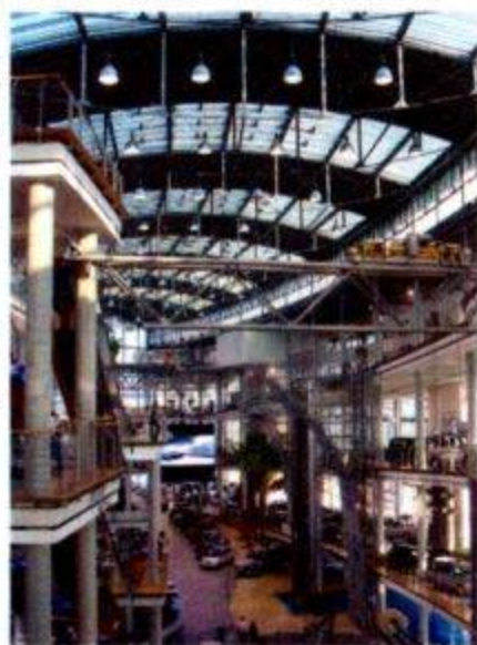
图2 玻璃采光顶实例
