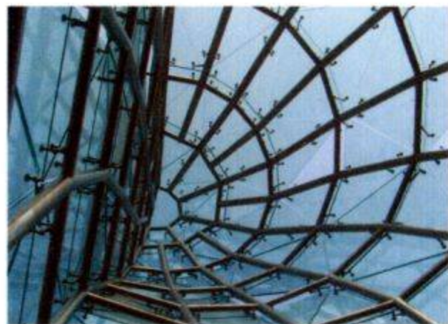
图1 玻璃采光顶实例仰视图
