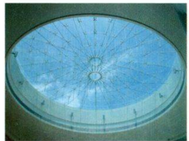
轮辐式拉索采光顶实例图片
