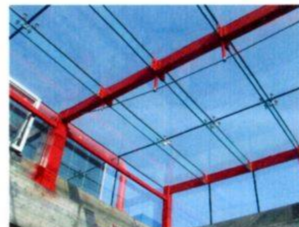
玻璃梁结构采光顶实例1
