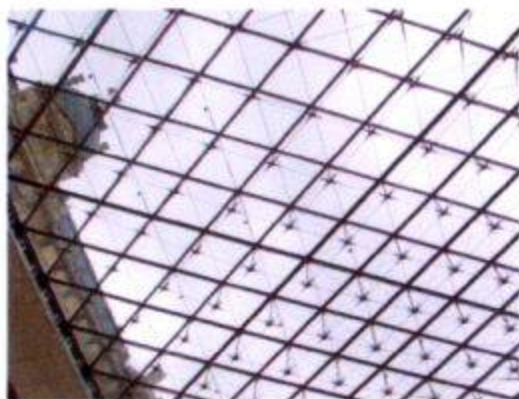
图3 拉索采光顶实例
