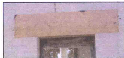
酚醛板可作为窗上口的防火隔离带
