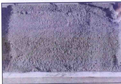
聚苯板上抹胶粉聚苯颗粒粘结料
