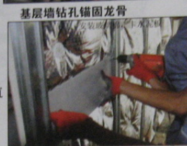
基层墙钻孔锚固龙骨
