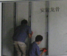
基层墙钻孔锚固龙骨
