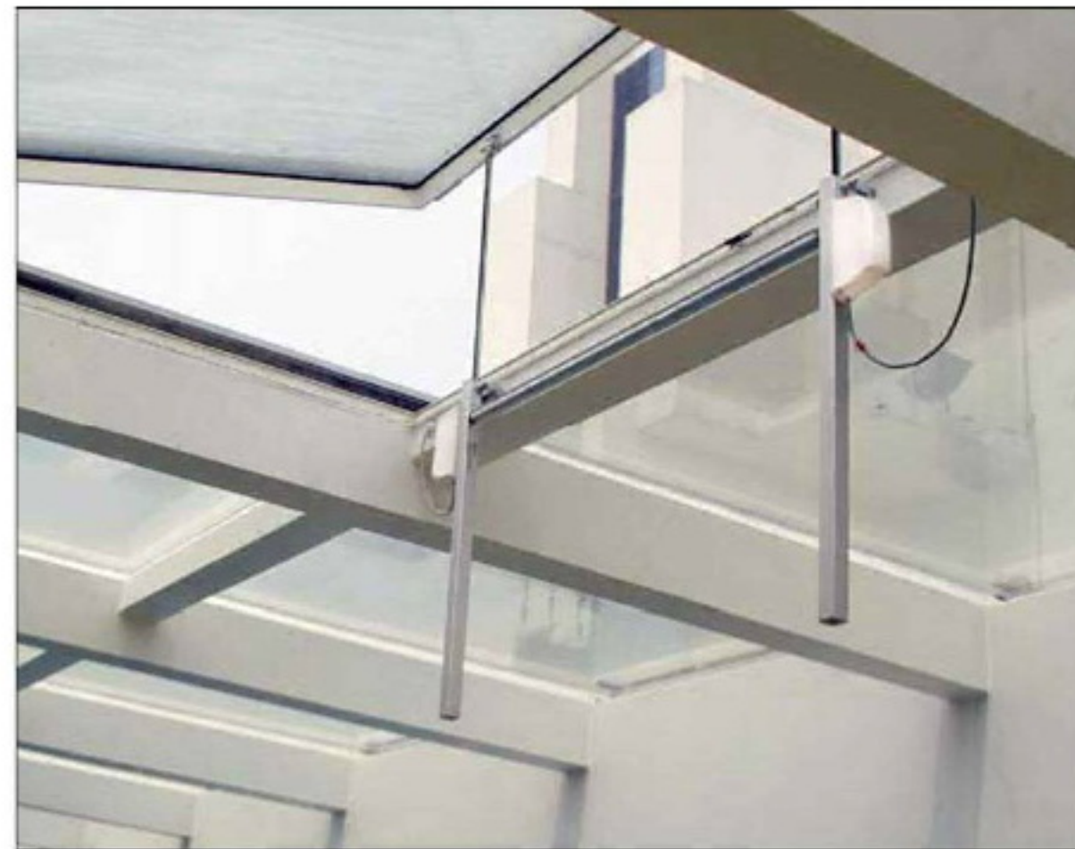
正正杆齿条式开窗机用于采光屋面
