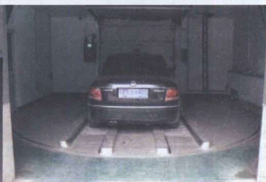
图C2-4 提升与回转机构
