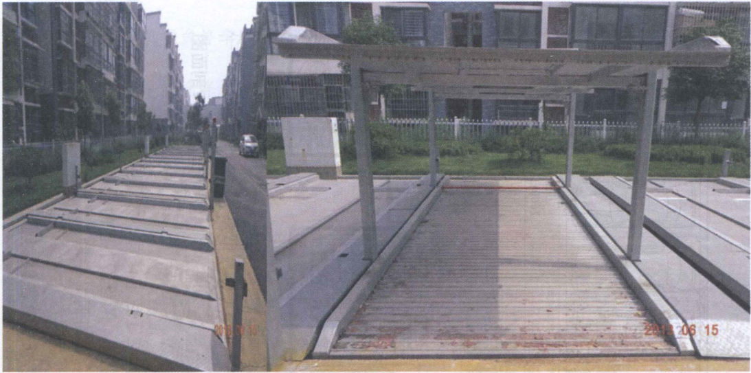
图B7-2 停车设备图(升起时)
