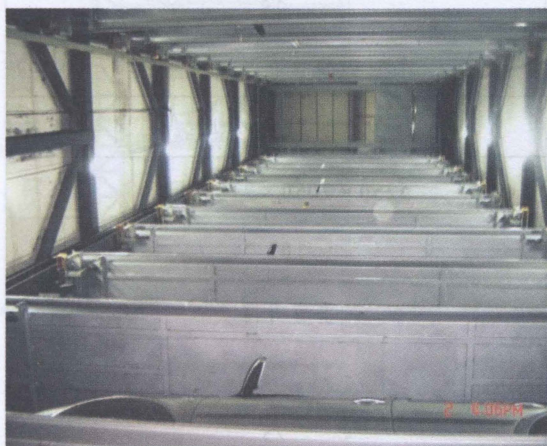
图C7-3 停车设备图(升降通道)
