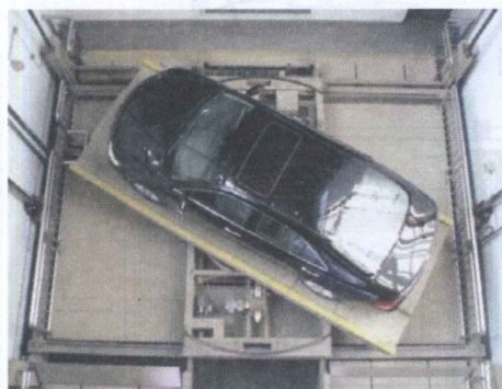
图C9-3 设备升降系统（旋转时）
