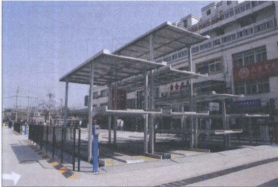
图B2-5 停车设备图（升起时）
