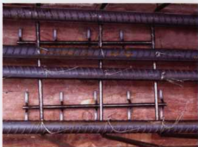
图1-26 金属类钢筋间隔件(二)
