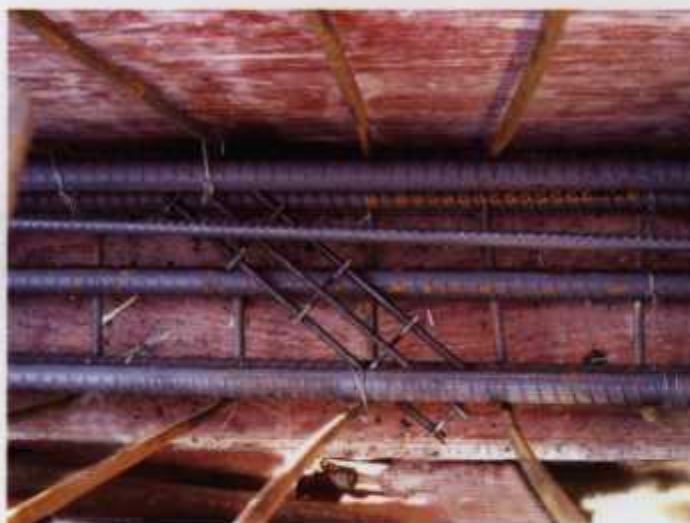
图1-26 金属类钢筋间隔件(二)
