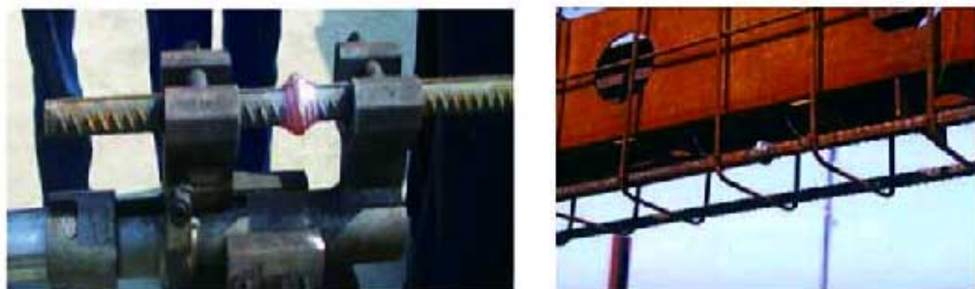
(a) 加热加压的钢筋接头呈红热竹节状 (b) 钢筋气压焊用于钢筋连接的工程实例
