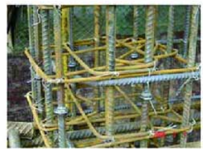
(b) 敲除渣壳后的电渣压力焊接接头
