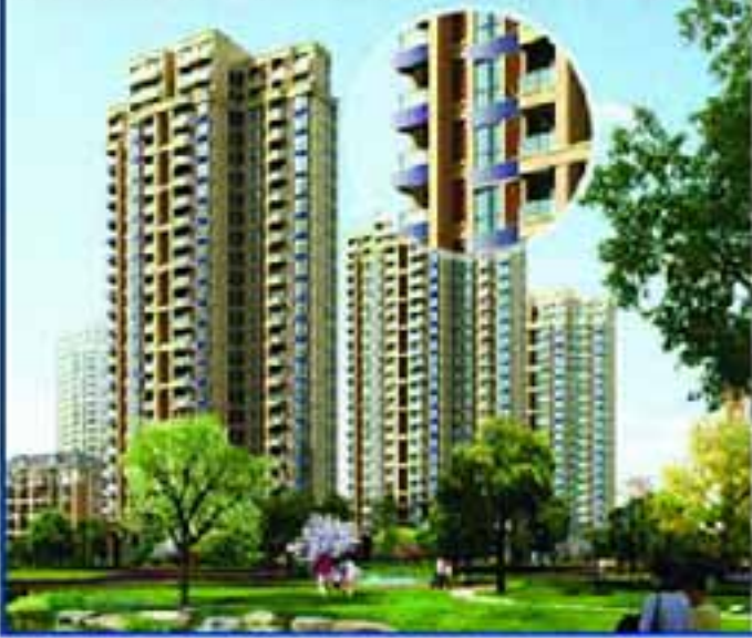
分户集热、分户储热系统 (阳台壁挂式)
