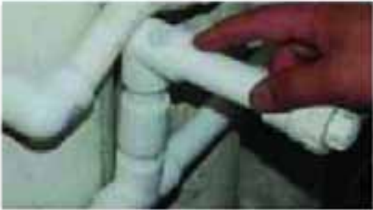
普通工艺焊点密集，施工困难，漏水隐患大
