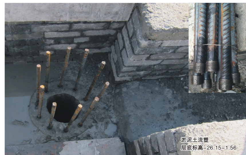
抗拔桩与承台连接构造图 (成功标准: 开挖每次不超过1米, 打桩按照垂直度标准控制, 抗拔连接可靠, 灌芯要求按照规范)
