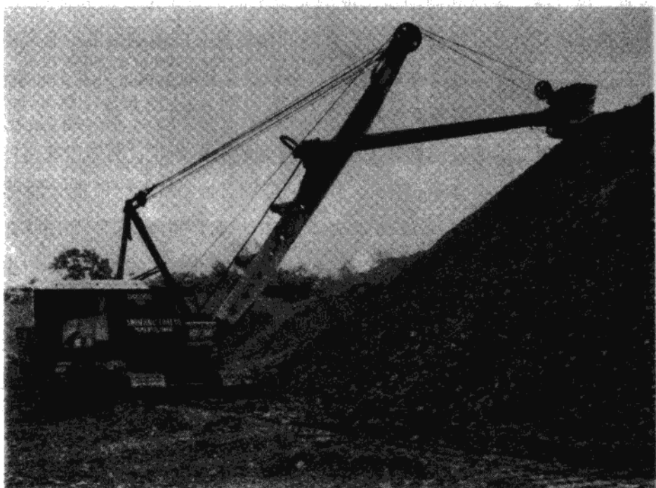
图3.1 Osgood General 公司制造的缆控机械铲土机
