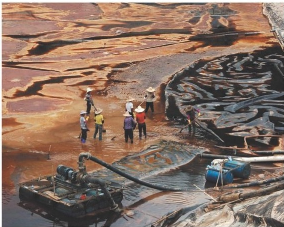
► 2010年7月，上杭紫金矿业集团股份有限公司紫金山铜矿湿法厂污水渗漏事故。图为7月13日，工人正在处理位于福建上杭紫金山铜矿湿法厂污水池中的含铜酸水。
