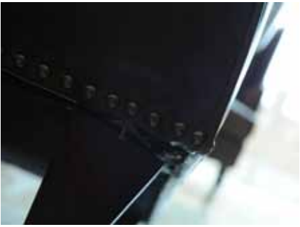
家具定制的细节是品质的保证，图中家具的钉子露在外面，不美观且有危险性。
