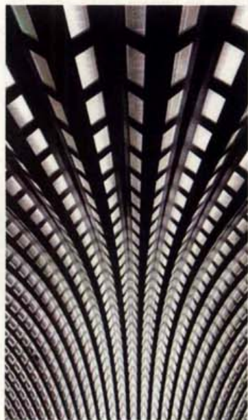
图9-43 意大利都灵展览馆采用波形装配式薄壳屋顶，1950年，建筑师：内尔维
